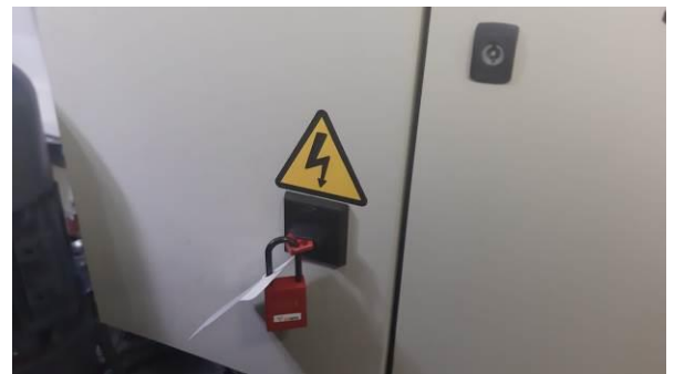
Consignación del seccionador Q321.
